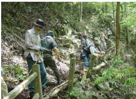
遊歩道の整備
