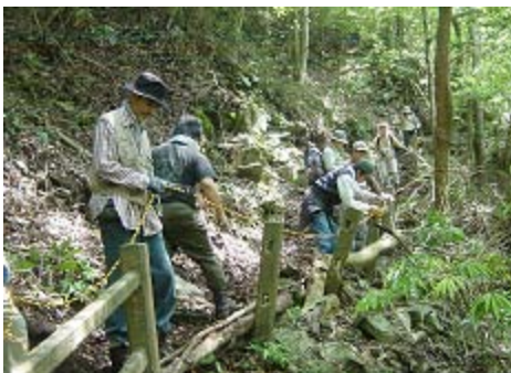
遊歩道の整備
